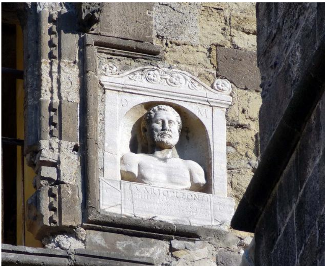
6. Il campanile della Cappella Pappacoda (particolare)
